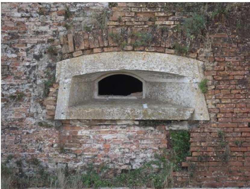
Da questa apertura, che sembra a prima vista una cannoniera, veniva tirata una catena che, attraversava il braccio di mare tra il forte San Felice e l'opposto forte Caroman, ed impediva il passaggio e il conseguente ingresso al porto di Chioggia e alla laguna, ad imbarcazioni nemiche o comunque non desiderate.
