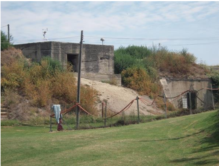
Una delle postazioni contraeree presenti nell'area del forte.
