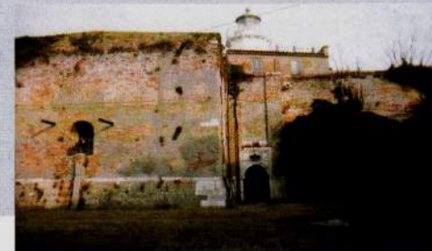
Torre e porta di accesso all'antico Castello.
